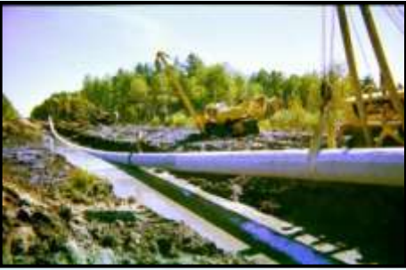
5. COLOCAR TUBERÍA
