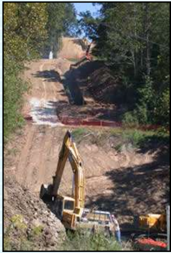
1. LIMPIEZA DE SERVIDUMBRE
