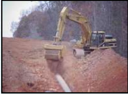
6. RELLENAR TRINCHERA
