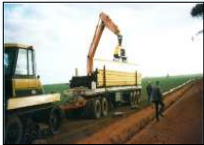
3. ALINEACIÓN DE LA TUBERÍA
